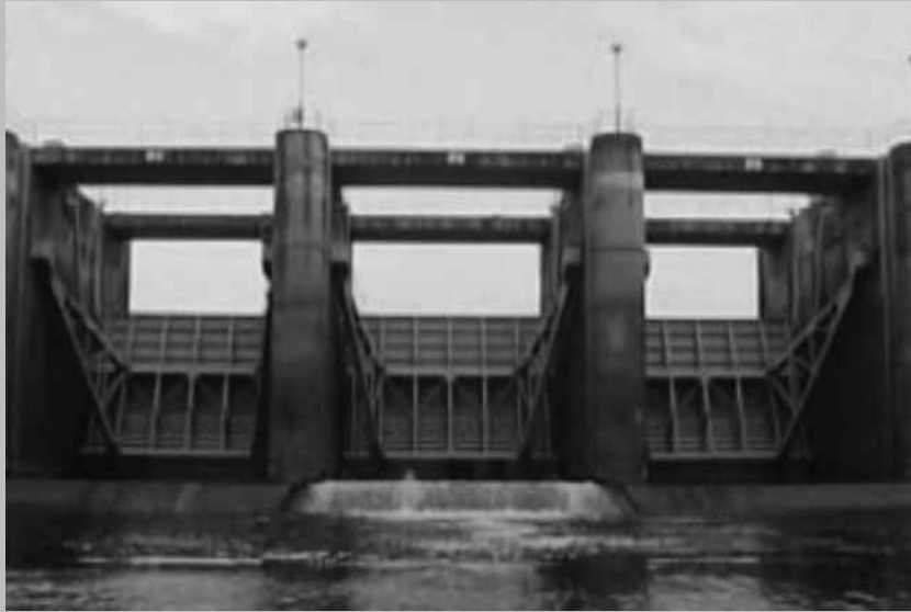
เขื่อนราษีไศล เป็นเขื่อนคอนกรีต มีบานประตูระบายน้ำ 7 บาน กั้นแม่น้ำมูลที่บ้านห้วย-บ้านดอน ตั้งอยู่ อ.ราษีไศล จ.ศรีสะเกษ ได้รับอนุมัติให้มีการก่อสร้างตามอภิมหาโครงการหลายแสนล้าน โขง ซี มูล ในสมัยรัฐบาล พล.อ.ชาติชาย ชุณหะวัณ
